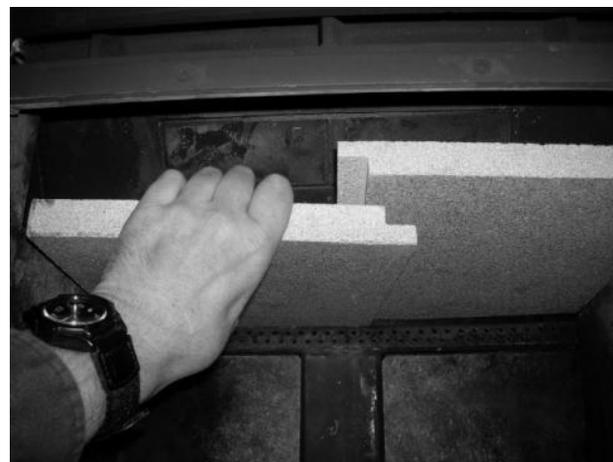
**Figure 16 – Enlèvement/Remplacement du Déflecteur pour Inspection**
